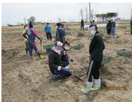
畑のがれき撤去作業では、がれきがたくさん出てきました。
