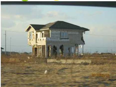
沿岸部には津波の被害を受けた建物がまだ残っていました。
